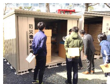
↑ 涌谷町が管理している防災倉庫 （体育館前）
